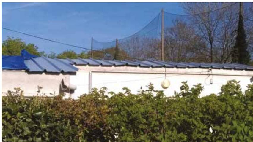
**L'opération de travaux consistait à remplacer la couverture actuelle, constituée de plaques ondulées en fibrociment contenant de l'amiante, par une couverture en tôles d'acier nervurées laquées (bac acier).** Nous avons profité de l'absence de couverture, compte tenu de la présence intérieure de plafonds non démontables, pour mettre en place une isolation en laine minérale.
